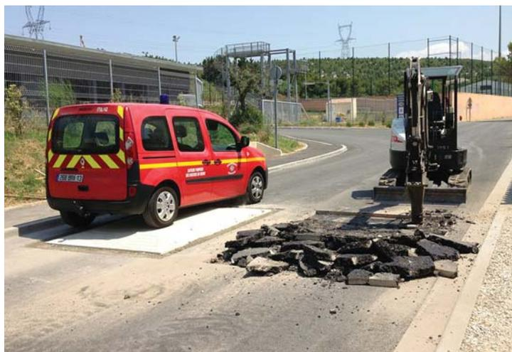
Devant le Centre de Secours, pose de ralentisseurs afin de limiter la vitesse en ce lieu de sorties de véhicules et d'accès au bouledrome municipal.
