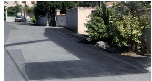
Une partie du revêtement bitumeux au niveau de l'angle entre le Chemin des Pachons et le chemin du Vieux Jas a été repris afin de faciliter le croisement des véhicules et les entrées-sorties des riverains sur ce secteur.
