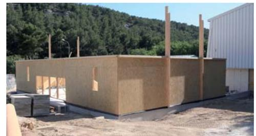
Les travaux de construction de la nouvelle salle de gym agrès avancent à grand pas. Dans l'objectif de construction d'un bâtiment qui intègre les règles de Haute Qualité Environnementale (HQE), la structure de bâtiment est en bois en attendant l'arrivée des panneaux d'habillage extérieur fabriqués eux en résine de bois.
