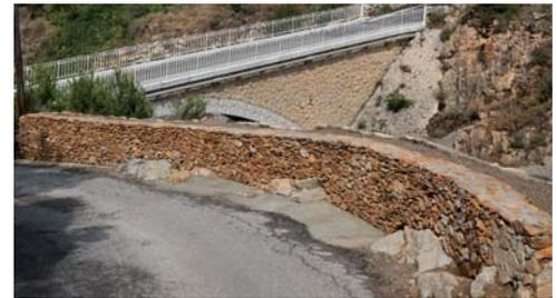
Afin de sécuriser la circulation routière à l'impasse des cigales, un muret en pierres a été construit afin de se prémunir de tous risques de chute de véhicules sur la ligne SNCF de la Côte Bleue située en contrebas.
