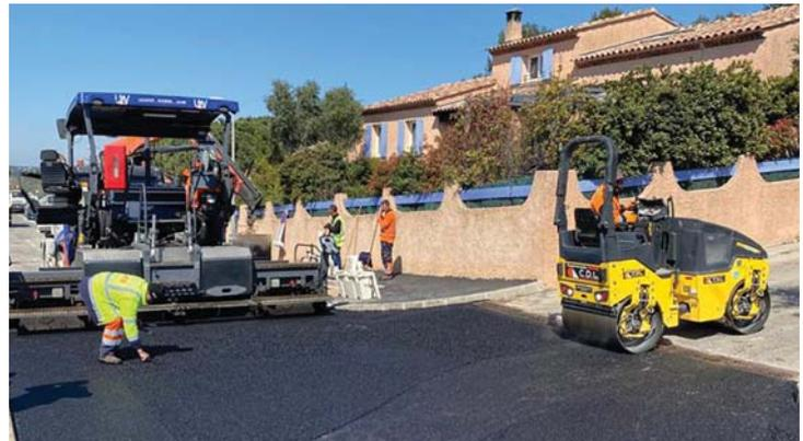
Dans le cadre du programme d'entretien en collaboration avec les services voirie-circulation de la Métropole, nous avons poursuivi la remise en état des trottoirs et de la chaussée sur la Promenade de Chantegrive. Les arbres à l'origine des déformations sur les voies ont été retirés et de nouvelles espèces adaptées seront replantées à l'automne. Les travaux vont se poursuivre par quelques reprises de chaussées encore nécessaires comme l'impasse des mésanges et l'allée des pinsons.
