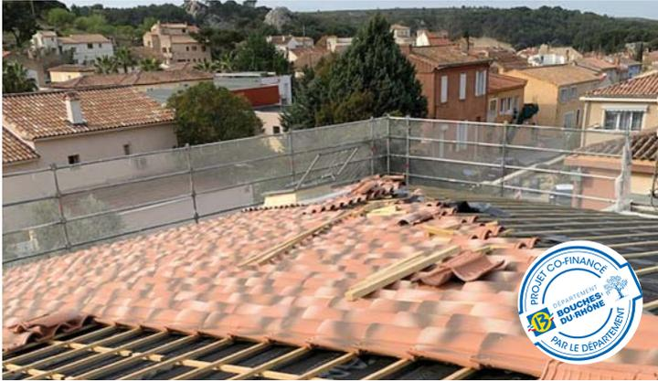
Les travaux de l'Hôtel de Ville qui ont démarré en janvier dernier se déroulent comme prévu suivant le calendrier prévisionnel défini. Pour rappel, ils consistent à réaliser la réfection et l'isolation de la toiture, le remplacement d'une partie des menuiseries dont les portes du sas d'entrée qui seront bientôt dotées de portes automatiques pour faciliter le passage des personnes à mobilité réduite et une meilleure isolation thermique du bâtiment par l'extérieur.
