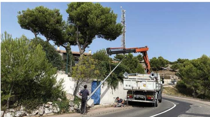
Poursuite du relanternage pour notre réseau d'éclairage public. Le remplacement des anciens modèles permet une meilleure intensité lumineuse, une durée de vie plus longue et surtout un gain en économie d'énergie de l'ordre de 50 % pour chaque nouveau point lumineux.
