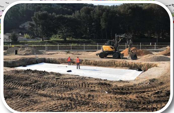
Un bassin de rétention bien dimensionné permet de régler le problème des flaques d'eau et de la boue qui envahissaient l'ancien parking à la moindre pluie
