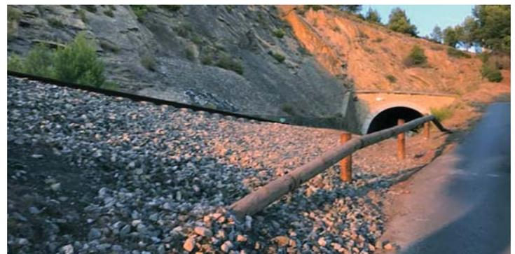
La route entre la Redonne et grand Méjean qui longe la voie ferrée s'avérait dangereuse par endroit avec un risque de dérivation des voitures vers la voie ferrée. Il s'avérait nécessaire de sécuriser les portions les plus accidentogènes. Des glissières ont été installées afin de réduire ce risque.
