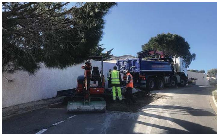
Le programme de réfection des voiries de Chantegrive s'est poursuivi coté flamands roses jusqu'au carrefour de la traverse des hérons. Les pins, dont les racines déformaient la chaussée ont été arrachés. Cela va permettre aux véhicules de circuler en toute sécurité, aux riverains d'améliorer l'accès à leurs propriétés et aux piétons de pouvoir marcher sur des trottoirs dignes de ce nom. De nouveaux arbres moins agressifs pour la chaussée ont été replantés.
