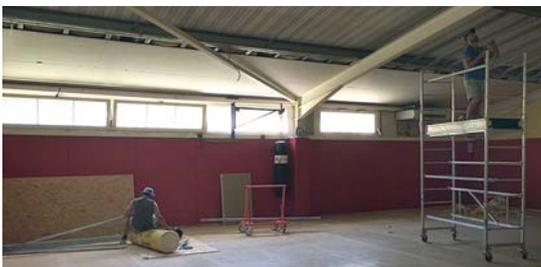
Suite au diagnostic énergétique des bâtiments, l'isolation des plafonds du dojo et de la salle de danse ont été réalisés cet été par l'ajout d'un faux plafond et la mise en place de laine de verre.
