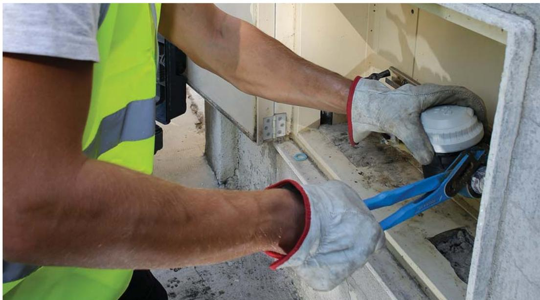
À Ensues la Redonne, durant le premier trimestre 2016, quelque 2 500 compteurs d'eau classiques vont être progressivement remplacés par des appareils télé-relevés, par la Société Eau de Marseille Métropole. Quelques explications : les nouveaux compteurs d'eau s'appuient sur une technologie qui présente bien des atouts. Sur le plan pratique, le relevé à distance s'effectue automatiquement, sans déranger les habitants.
